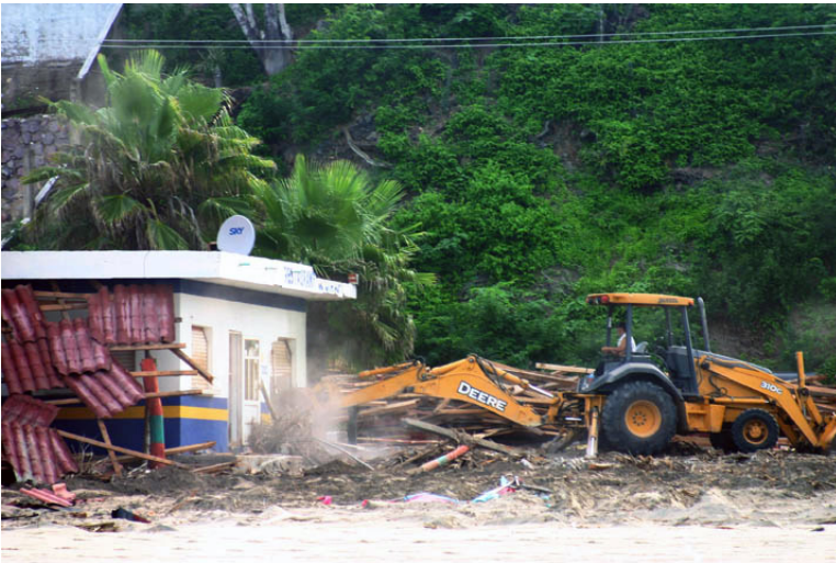
Imagen 4. Demolición de restaurante El Chato en Tenacatita (Fotografía: Emmanuel Díaz, 2010).
