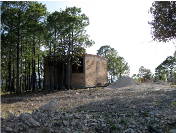
Imagen 6. Casas habitación construidas para reubicar a la comunidad de Mogotavo. (Fotografía: Horacio Almanza, 2010).
