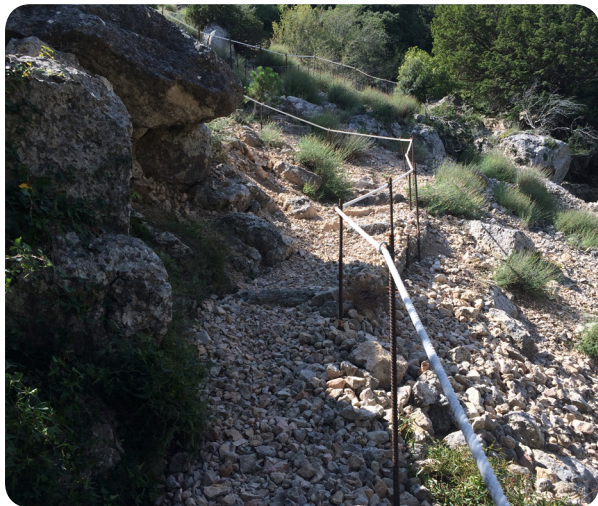
Figura 3. Acondicionamiento de sendero con una malla baja (altura de 30 cm) de acero galvanizado de triple torsión, que pasa por la parte inferior del firme rocoso y anclada con hilo de acero galvanizado en las barras de la barandilla aguas arriba. Tejada de Cosp (Serra de Cardó). Foto: Jordi Camprodon.
