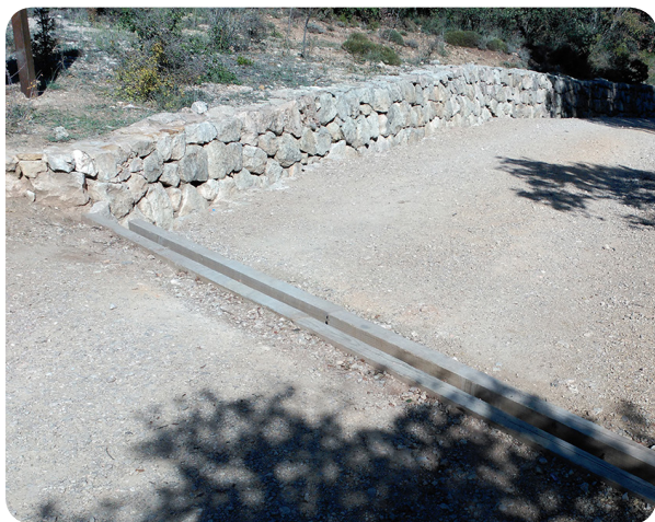
Figura 4. Surco oblicuo en el camino, protegido por traviesas de madera para romper el flujo de agua por el medio del camino y evacuar el agua. Parque Natural de la Font Roja, Alacant. Foto: Joan Llovet.
