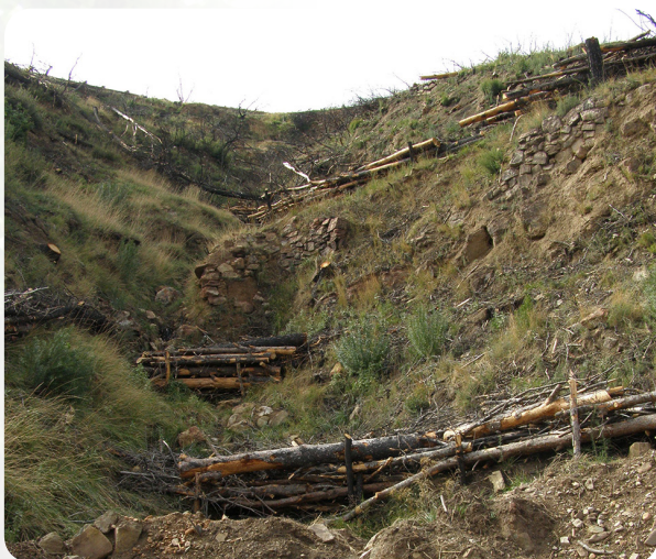
Figura 1. Fajinas o muretes de troncos y ramas como impedimento a la escorrentía de agua superficial y para favorecer la infiltración y retener sedimentos. Para maximizar su efectividad es necesario que los materiales tengan un buen contacto con la superficie del suelo. Foto: Joan Llovet.
