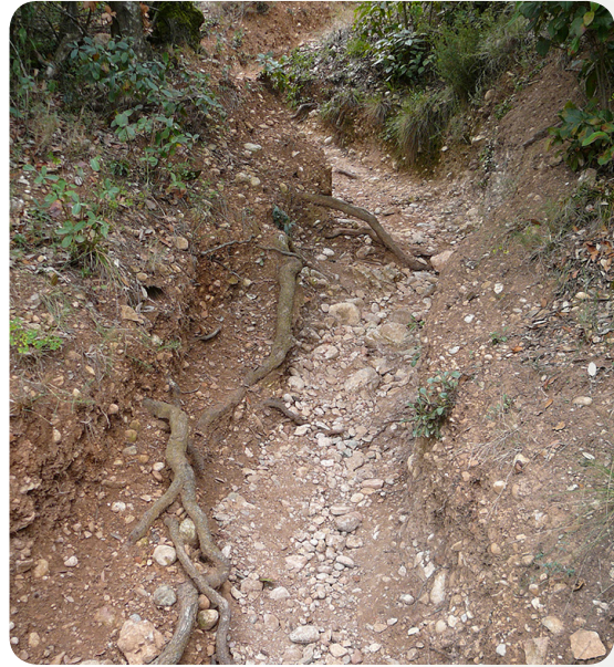
Figura 2. Camino afectado por erosión e inicio de cárcavas. Es de destacar la pedregosidad dominante por eliminación de los materiales más finos y la aparición de las raíces en el camino. Foto: Joan Llovet.
