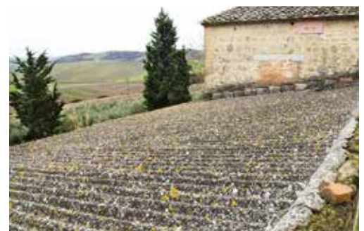
Las cubiertas en buenas condiciones se pueden dejar como están.
